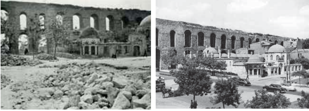
Fotoğraf 2. ve 3. Atatürk Bulvarı inşa açma çalışmaları ve sonrası 52
